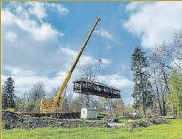
Die Fußgänger- und Radwegbrücke in Jussenweiler ist mit Einsatz von großem Gerät aus der Feldwerkstatt eingeflogen und wieder eingesetzt worden.
