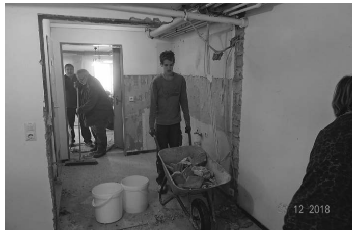
Küchenvergrößerung, die Zwischenwand wurde abgebrochen
