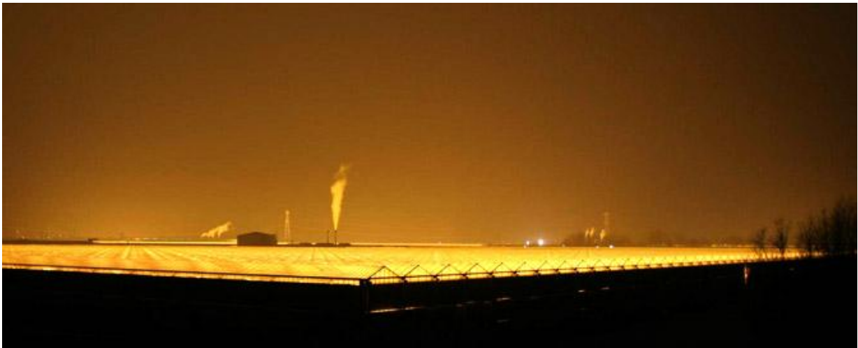
Abbildung 1: Beleuchtetes Gewächshaus in den Niederlanden. Die Gewächshäuser sind zum Teil viele hunderte Meter lang.
