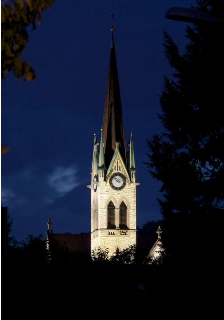
Abbildung 3: Projektionsbeleuchtung der reformierten Kirche in Zürich Wipkingen. Bei der reformierten Kirche in Zürich Wipkingen wurde die bestehende Flutlichtanlage durch eine Projektionsbeleuchtung ersetzt. Damit wurde nicht nur eine markante Einsparung von Betriebsenergie erreicht, sondern zusätzlich auch Blendung und Lichtverschmutzung eliminiert.
