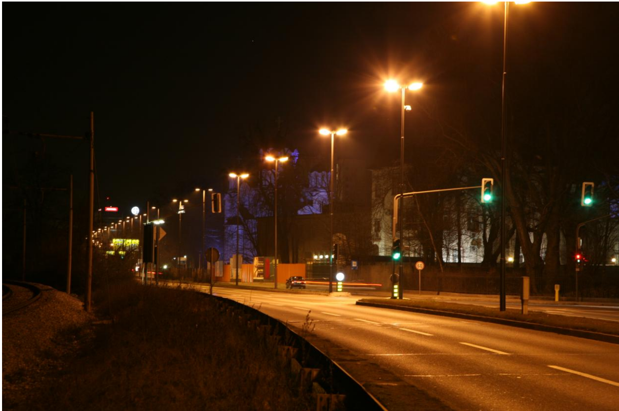
Abbildung 1: Ljubljana, Tivolska cesta während der Sanierung. Alte Lampen auf der linken Seite blenden recht stark; die neuen abgeblendeten Lampen blenden weniger, verursachen weniger Lichtverschmutzung und verbrauchen 40 Prozent weniger elektrische Energie.
